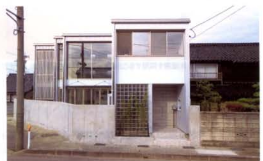
Y邸の外観デザインは「強い西日と交通騒音を遮断するための機能的な外壁(折り重なる4枚の壁)」がポイント。家の中の遮音性と快適性は、想像以上です。
