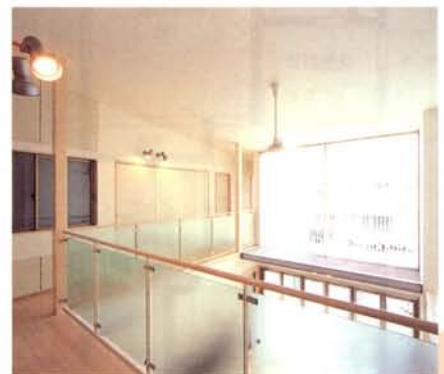
③吹き抜けを見下ろす2階ホール。大きな窓の足下に設置されたキヤットウォークは、光を軽減する作用のほか、メンテナンスにも役立っている。壁面にふんだんに設けられた収納にも注目したい。
