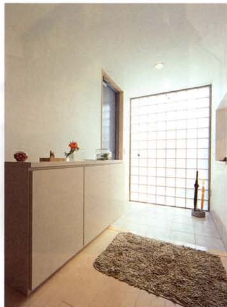
⑤ガラスブロックを採用した明るい玄関。光を取り込むことができるが、インテリアは外から丸見えにならない。
