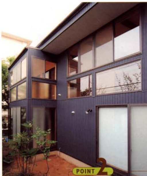
開口部を最小限に抑えた正面に対して、南側はほぼ全面を窓が覆う開放的な造り。庇を長くし、直射日光を遮っている。
