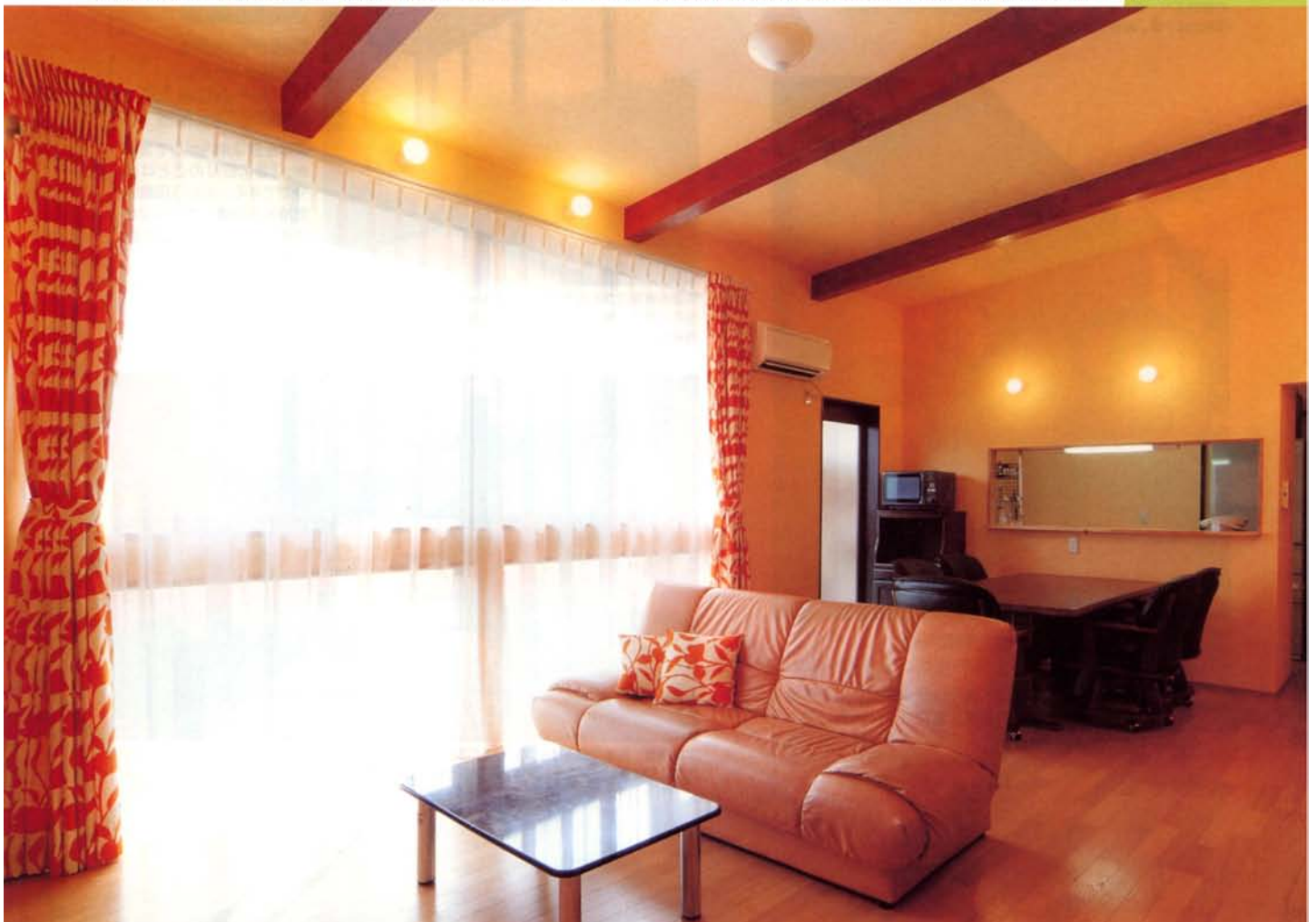
南側の壁一面の大きな開口部と最大3mの天井高により、明るく開放的なリビング。梁はペイマツを使用。Kさんはこの開放的な雰囲気を見て部屋を南欧風にすることを思い付いたそう。
