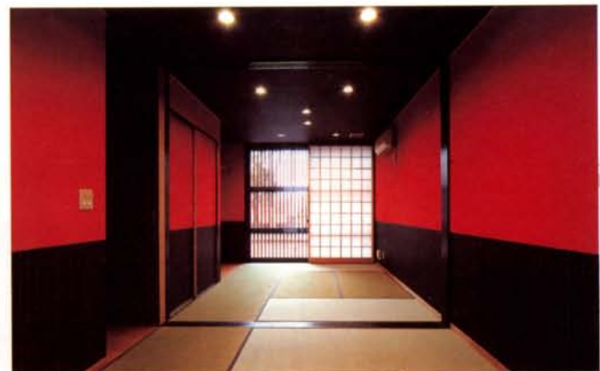
本格和室の障子壁をモチーフにした二間続きの和室。3枚引き戸により空間を分割できる。また、床から天井までを覆うサッシは、既製品としては最大の高さ2370ミリのものを使用した。
