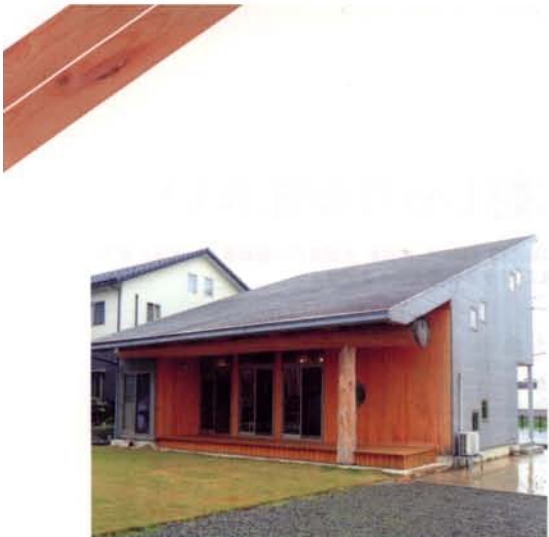
スキーのジャンプ台を思わせる片流れの屋根。奥行き3mに及ぶ軒は、デッキを雨から守り、真夏の強い日差しを遮ってくれる。
