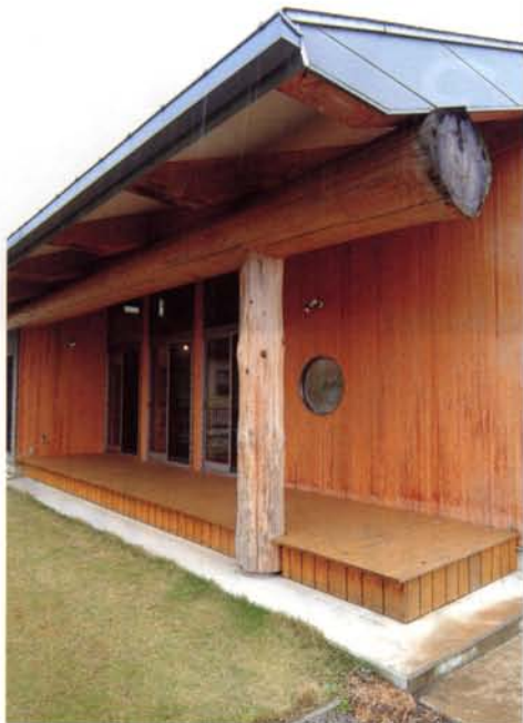
切り出した杉で造られたデッキテラスは、奥行き1.8m、長さ9m。極木の杉の丸太を用いた縁桁はT邸のシンボル。
