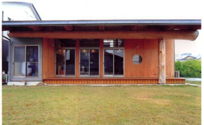
ゆとりある敷地のT邸。建物を敷地の北側に寄せるように建てることで、南側には広い芝生の庭を設けた。ウッドデッキ周りの外壁にはパイン材を張り、より木の質感が楽しめる空間とした。
