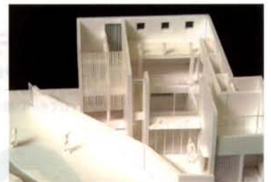
採光や通風のチェックを高い精度で行なうために、かなり緻密に作り込まれた建築模型。
